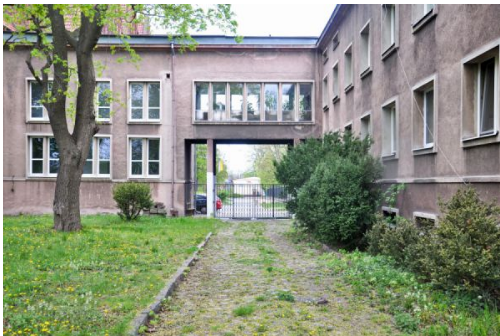
Nasz klasztorny ogród i brama, przy której trwają prace remontowe
