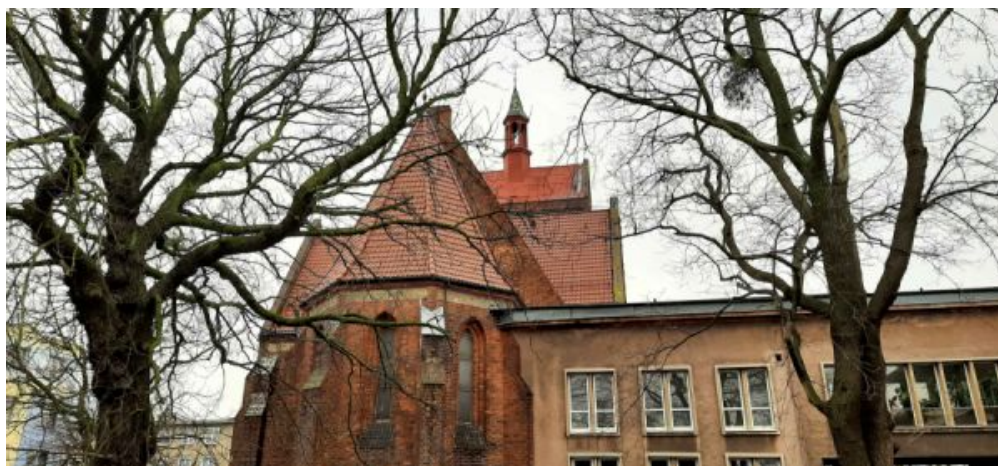
Widok na prezbiterium naszego kościoła.
