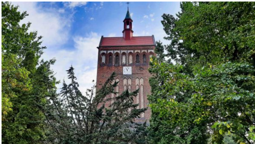
Widok na Kościół Morski od strony ulicy Oliwskiej.
