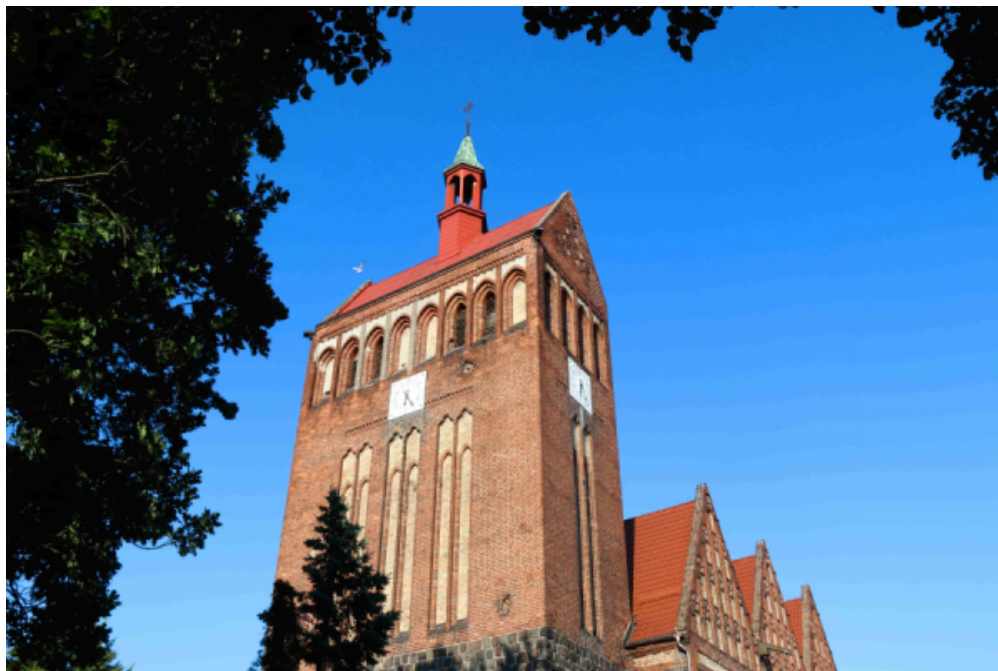
Widok na Kościół Morski od strony ulicy Oliwskiej.
