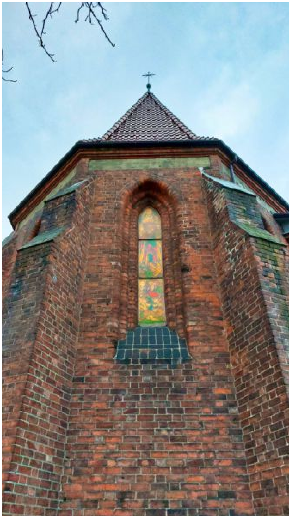
Widok na jedno z okien naszego prezbiterium w stylu gotyckim. Do cech tego stylu należy m.in. piramidalne zamknięcie okna w postaci łuku ostrego, obustronnie rozglifione ościeże oraz skośne parapety.
