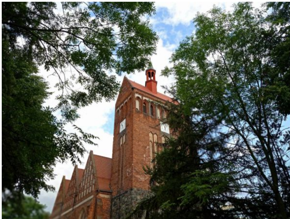
Widok na nasz kościół od strony ulicy Oliwskiej.
