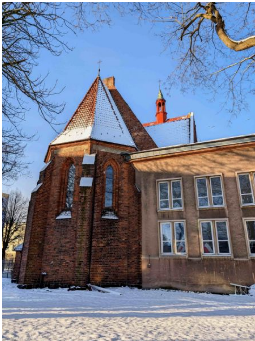
Zima nadal nie odpuszcza. Widok na nasz kościół od strony ogrodu klasztornego.
